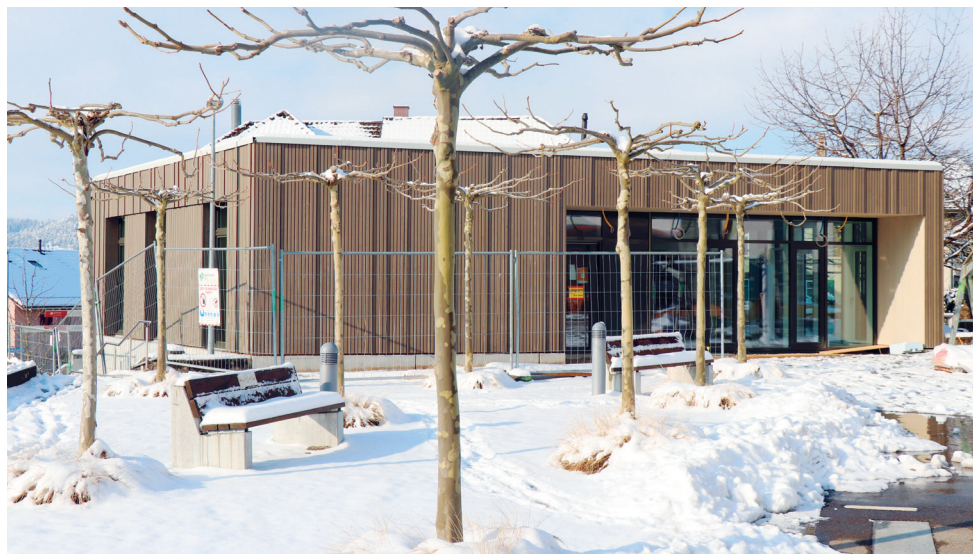
Neubau Pavillon: Kurz vor Bezug, Januar 2021
