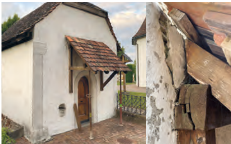
Eingangsvordach St. Anna-Kapelle
